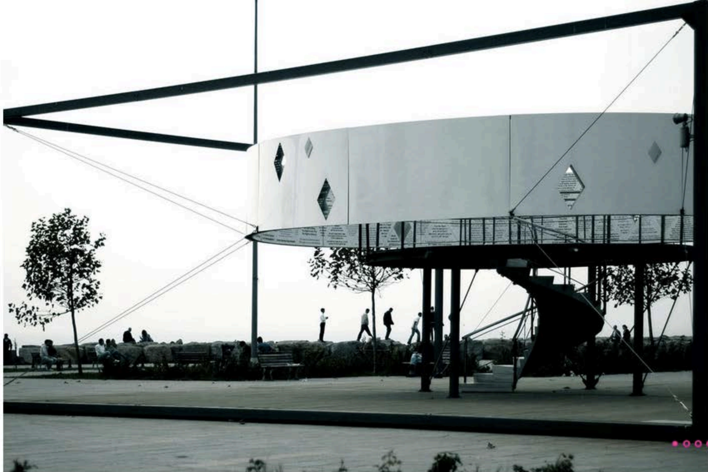
Una visione complessiva della struttura itinerante Panorama. Progetto Salon Architects
